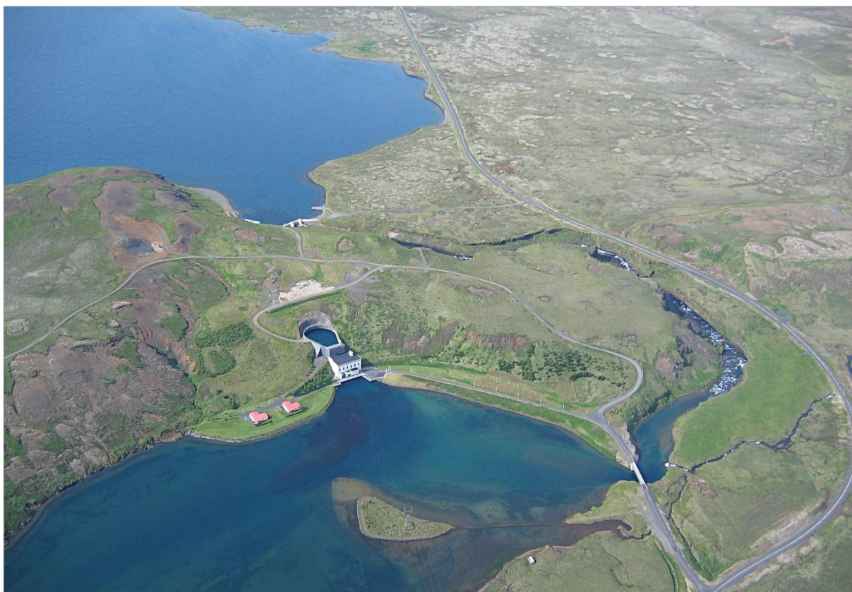
MYND 2. Steingrímsstöð og mannvirki tengd henni. Úlfjótsvatn neðst á mynd og Þingvallavatn efst. Mynd: Guðmundur H. Sveinbjörnsson.
