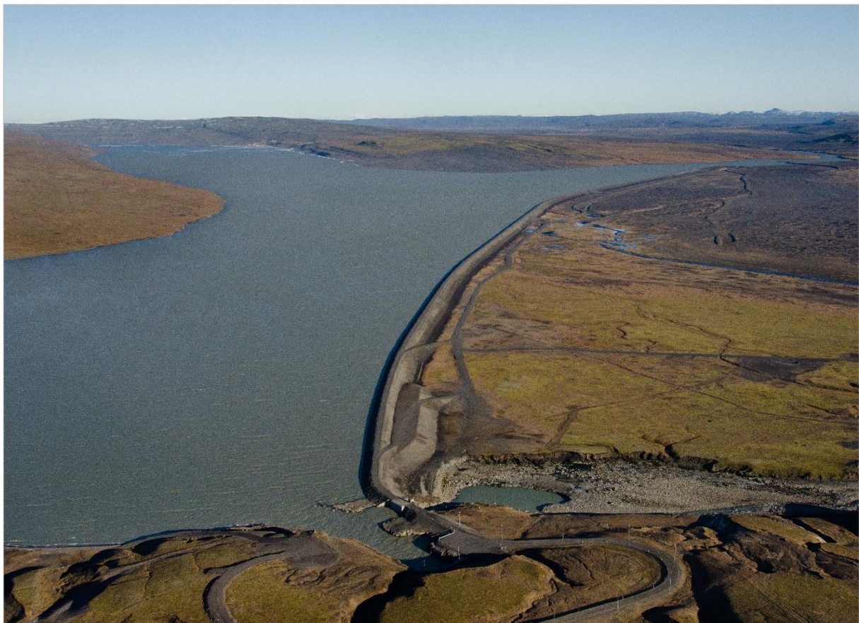
MYND 2. Horft til ANA yfir Sultartangalón og stíflu sem myndar það. Neðst á miðri mynd er botnrás og farvegur Þjórsár. (Mynd: Landsvirkjun).
