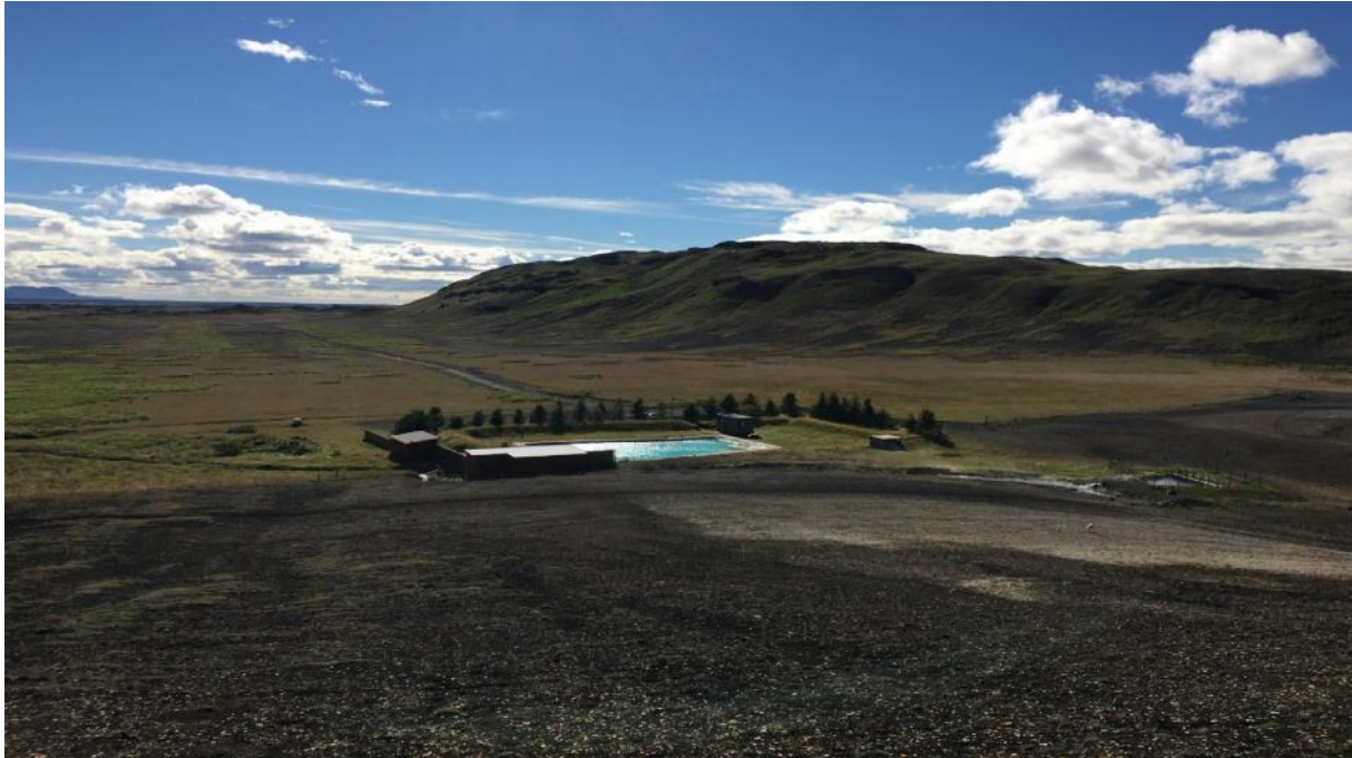
MYND 3 Horft yfir Þjórsárdalslaug ofan af Rauðakambi.
